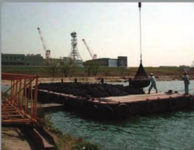
④ Laden Filter Unit op een ponton.
