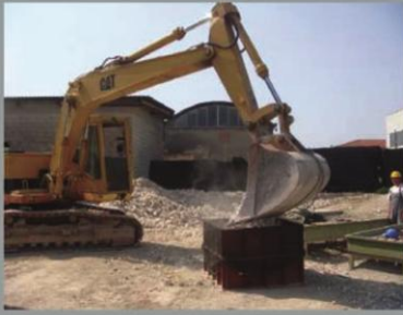
① Net aanbrengen in frame en vullen met steenachtig materiaal
